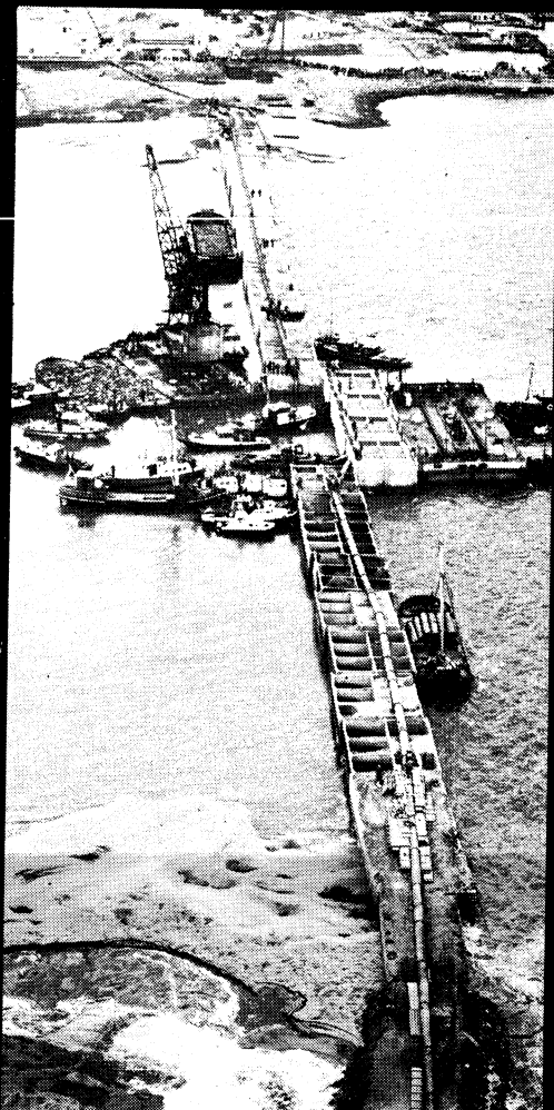
Ontwikkeling van de caissonsluiting gedurende de Deltawerken; afsluiting van de Zandkreek in 1960 (boven), het Veerse Gat, 1961, (links) en het zuidelijke gedeelte van de Grevelingen, 1962
